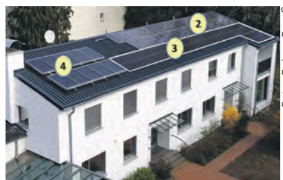
Saniertes Pfarrhaus in Bonn-Endenich: alte Fotovoltaikanlage 2, neue Fotovoltaikanlage 3, Solarthermie 4
